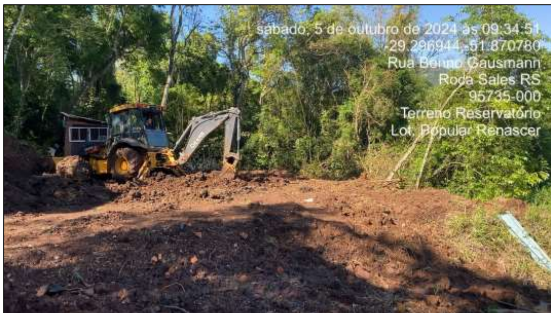
Figura 02 – Vista da sondagem Fonte: registrado pelo autor
