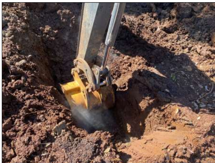
Figura 03 – Vista escavação do solo até o nível da rocha são impenetrável Fonte: registrado pelo autor
